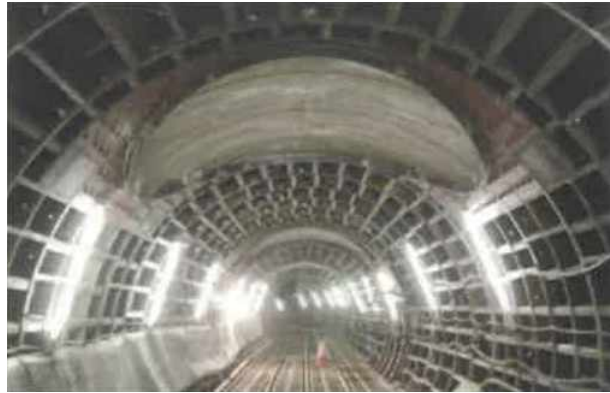
사진-13 상향실트의 FFU 세그먼트 9) (나고야시 메이역 미나미 우수간선)
