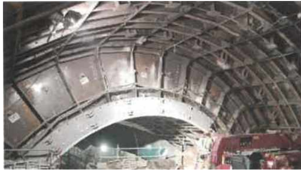
사진-12 확대실드 현황 13) (슈토고속도로 요코하마 칸조키타선 실드)
